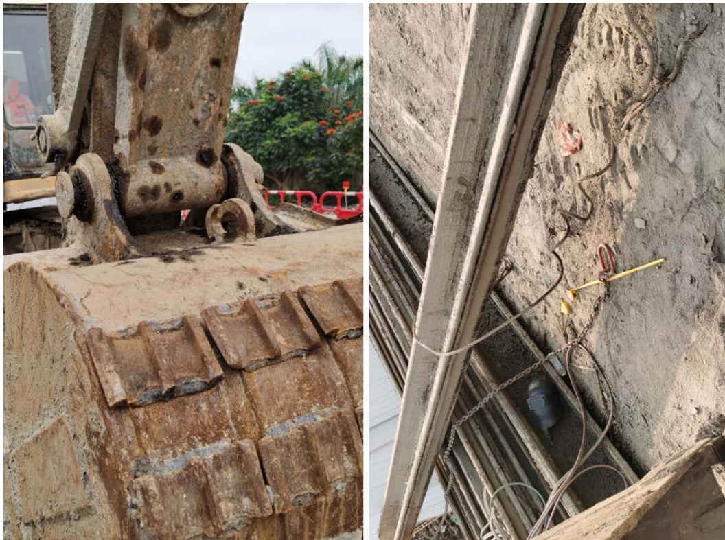
图三 挖掘机挖斗后面的挂钩及起吊所用的钢丝绳
