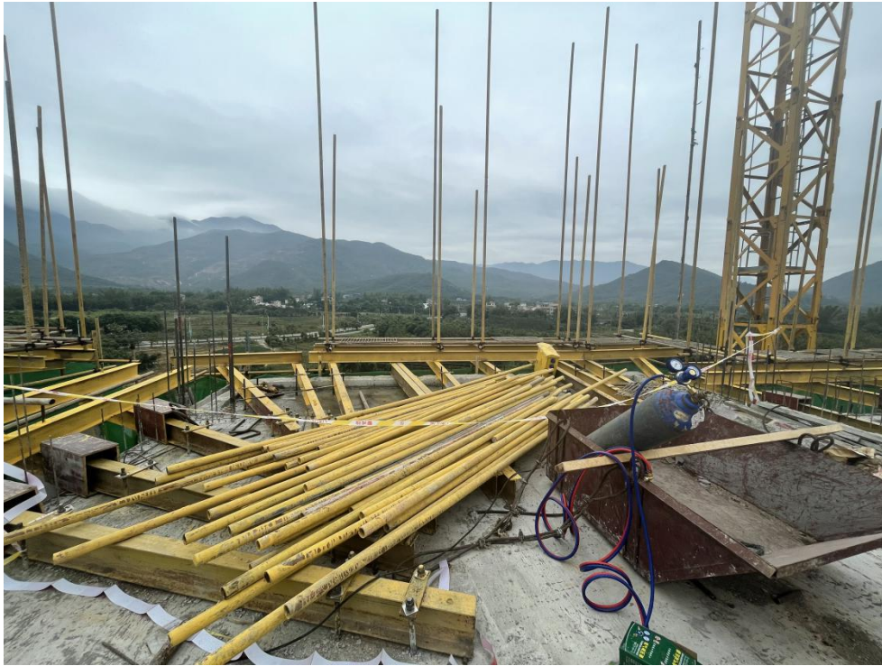
图四 使用的切割设备及钢管
