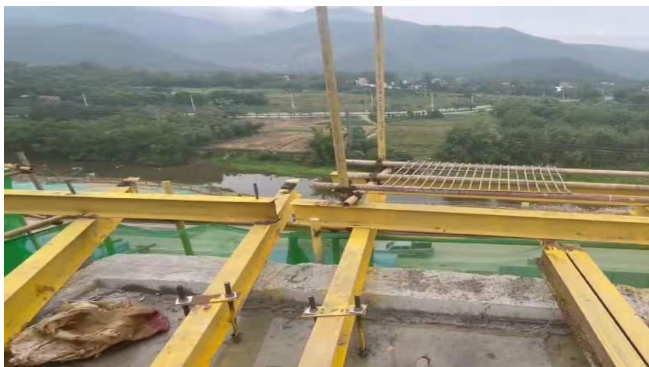
图三 被切割的工字钢位置
