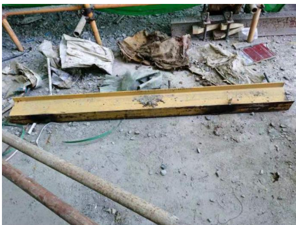
图五 坠落的工字钢
