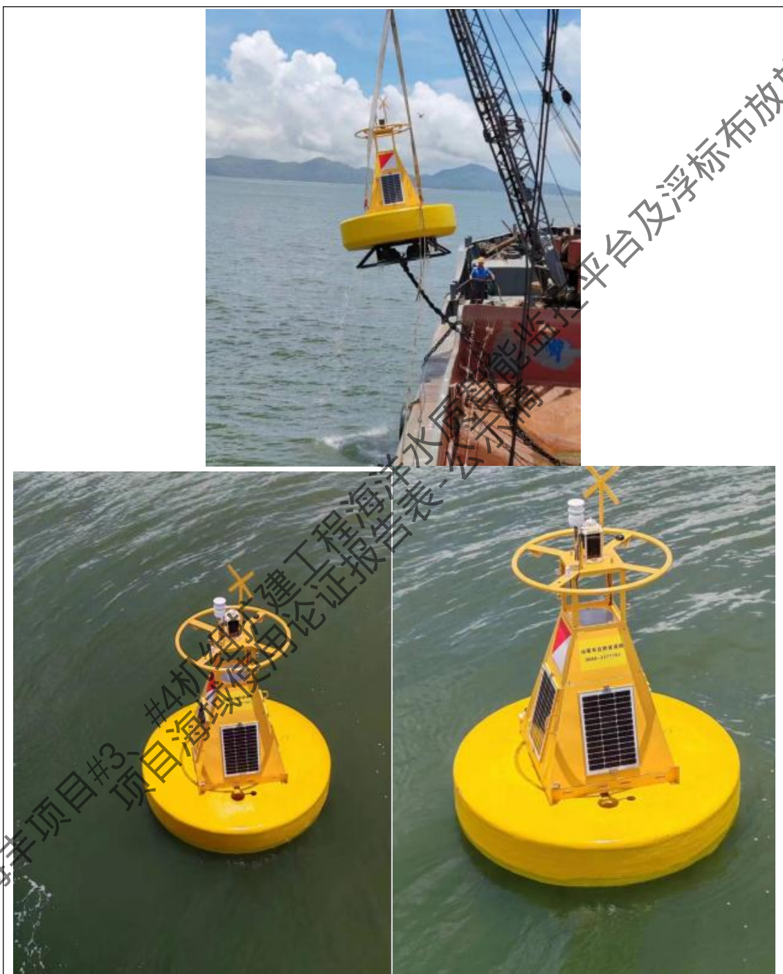
图 1.5.3-6 浮标下放和入水现场照片
